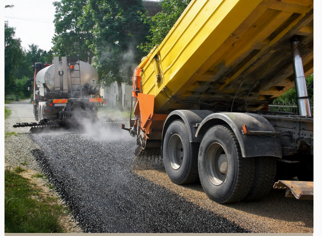
İnşaat ( Yol Yapımı)
